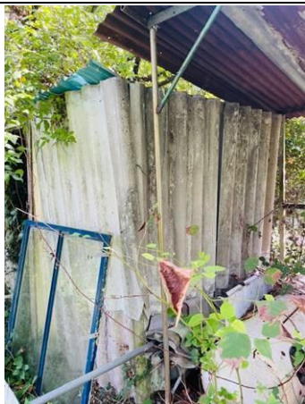
Photo n° PhA005 Localisation : Extérieur - Jardin; Extérieur - Abri de jardin 1 Ouvrage : Murs, Cloisons "en dur" et Poteaux (périphériques et intérieurs) Partie d'ouvrage : Revêtements durs (amiante-ciment) Description : Revêtements durs (amiante-ciment)
